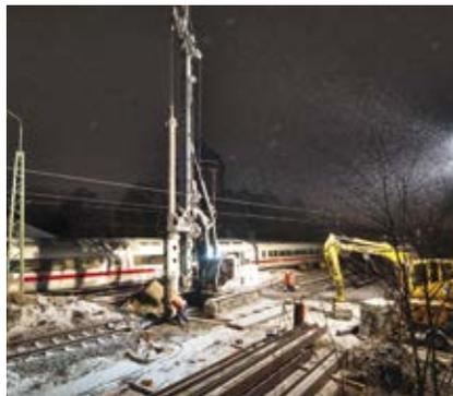
Bohrgerät beim Herstellen der Verbau-träger
