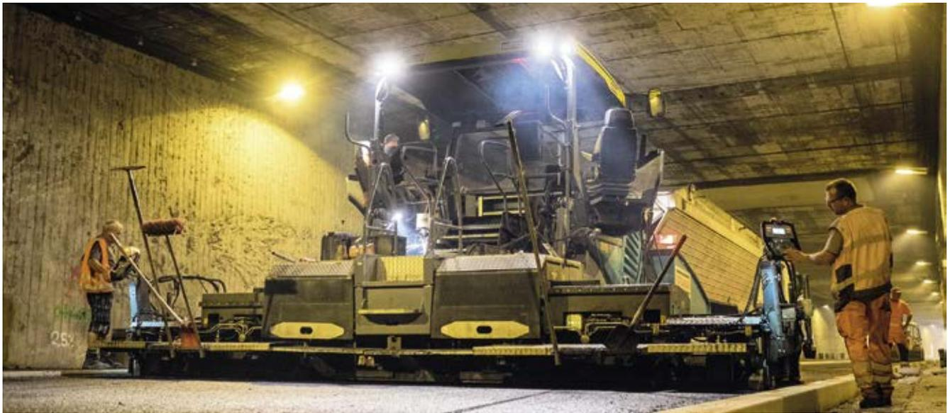
Einsatz des Fertigers für die Asphaltdeckschicht während der Sommersperrung 2015
