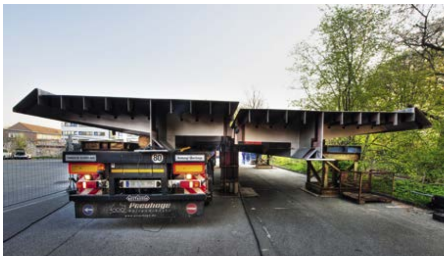
Lagerung der Brückenteile
