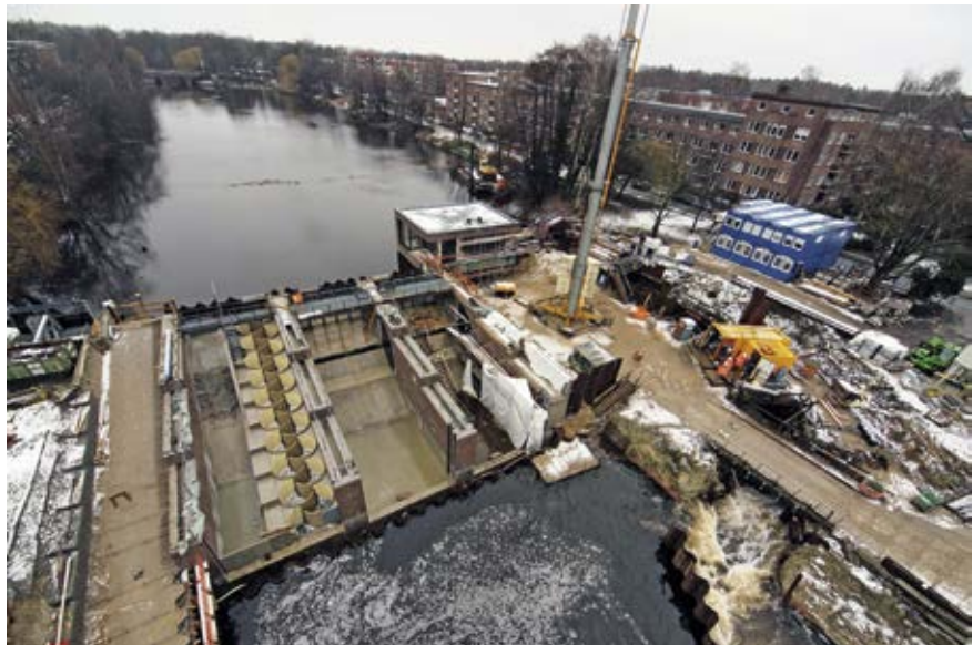
Umbau der Schleuse zum Wehr mit Mäanderfischpass
