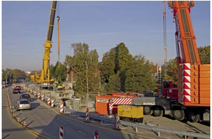
Abbruch nördlicher Überbau
