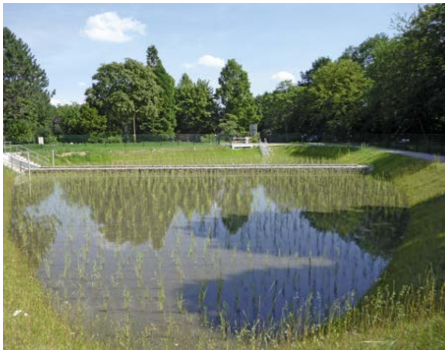
Retentionsbodenfilter während der Schilfetablierung
