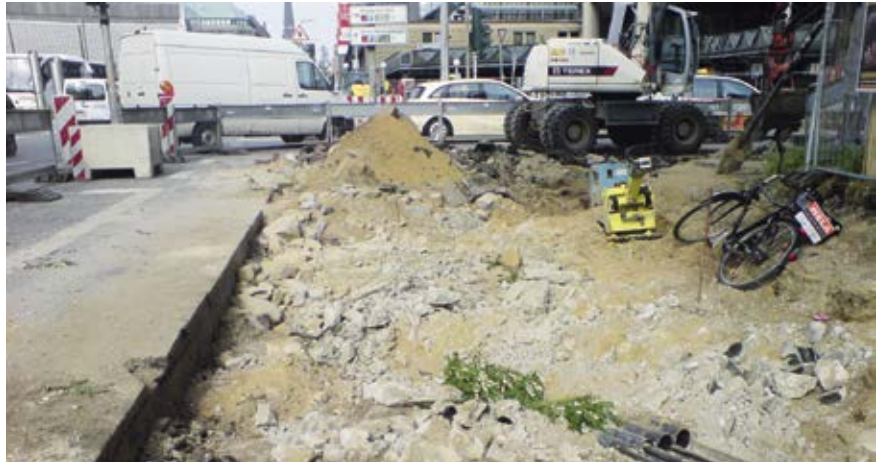
Herstellung des neuen Radwegs
