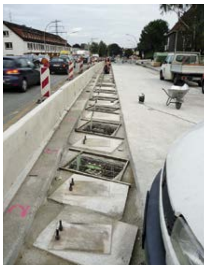
Einbau der Klemmverankerungen
