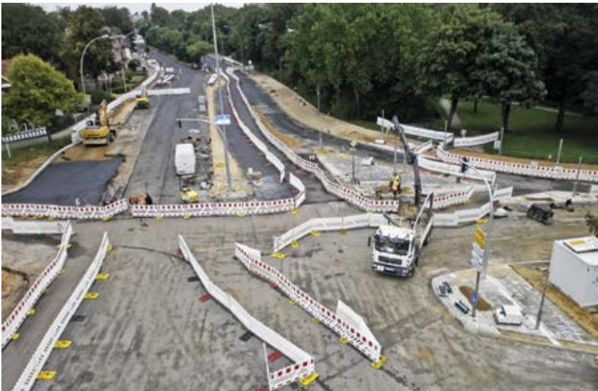
Umbau der Kreuzung im September 2013 unter Vollsperrung
