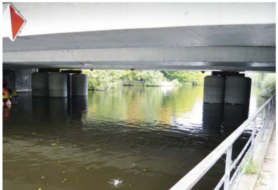
Notunterstützungen unter dem nördlichen Hauptträger
