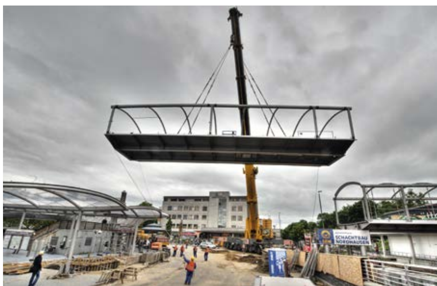
Einhub der Fußgängerbrücke
