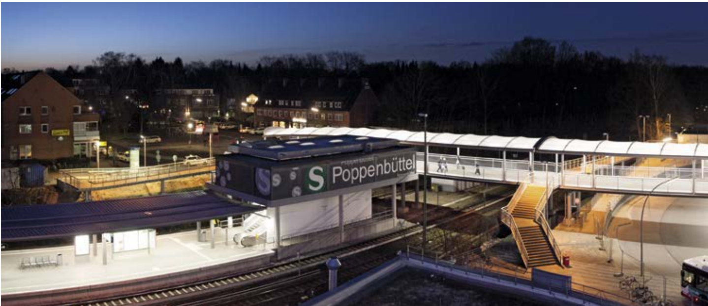
Die fertige Fußgängerbrücke
