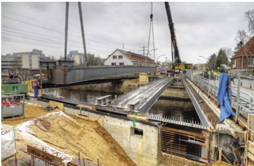
Einbau der Stahlträger für den südlichen Überbau
