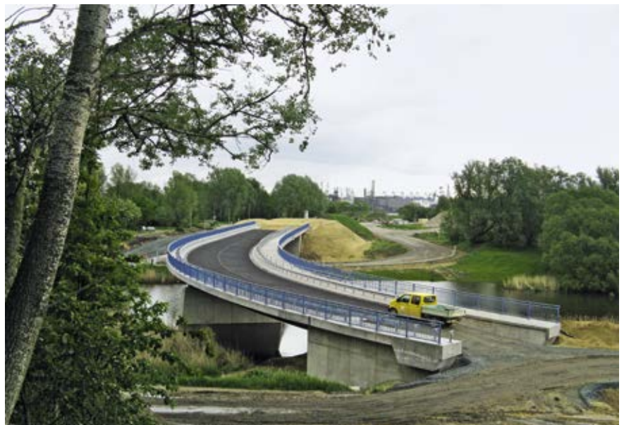
Umgehung Finkenwerder – Brückenbauwerk 01 über die Alte Süderelbe
