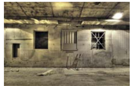
Elbtunnel –Tunnellüftung, Klappeneinbau
