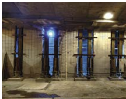
Elbtunnel –Tunnellüftung, Vorbereitung Stützen
