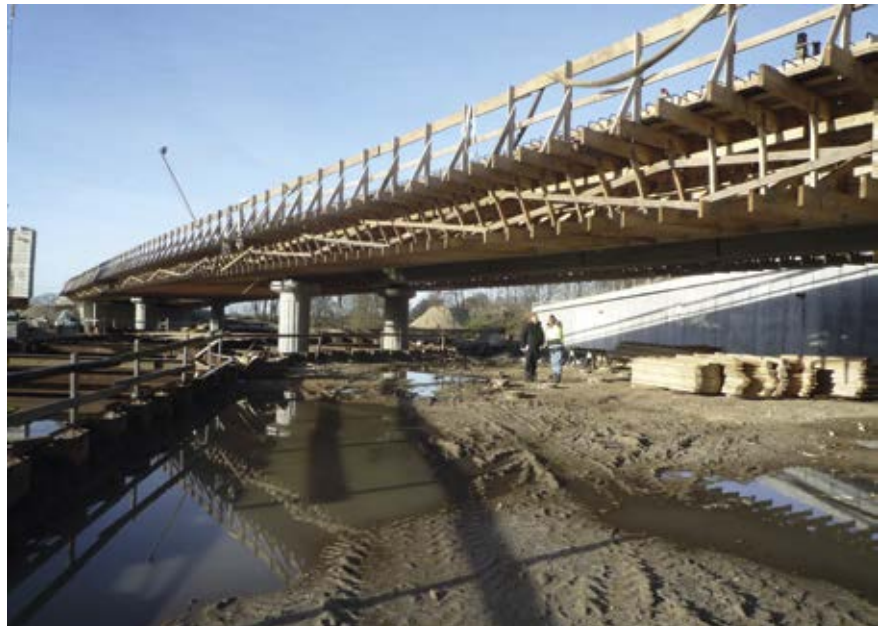
Umgehung Finkenwerder – Brückenbauwerk 02 über den Haakengraben
