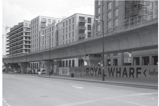
Abb. 05: DLR Stadtbahn mit dem baulich kompakten Stadtquartier Royal Wharf
