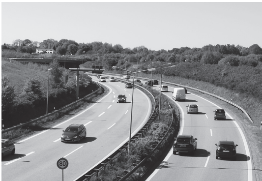
Abb. 08: Landseitige Erschließung Hamburg Airport, Zeppelinstraße
