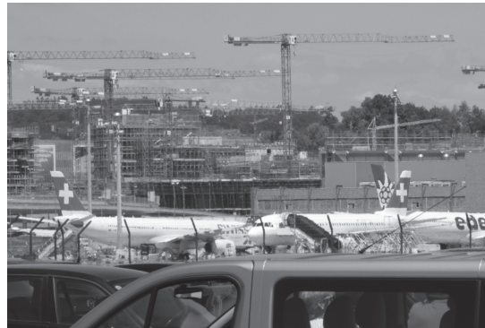
Abb. 06: Baustelle „The Circle“ Flughafen Zürich
