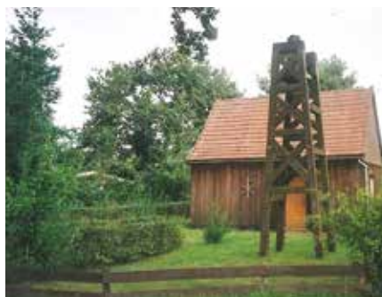
Das Original: Dessen Glockenturm errichtete Markus Rätth 1990 ehrenamtlich in Schwanheide.
