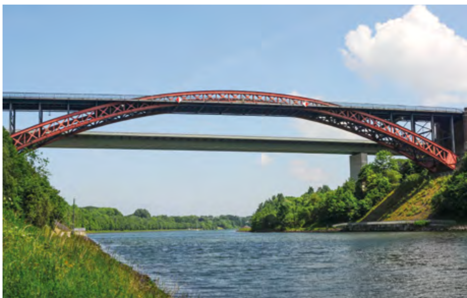
Abriss nach 130 Jahren: Levensauer Hochbrücke bei Kiel
