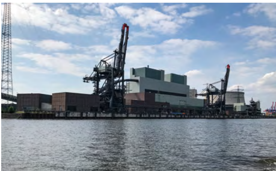
Das Gelände des Kohlekraftwerks soll Wasserstoffzentrum werden
