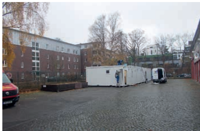
Die aufgestellten Container
