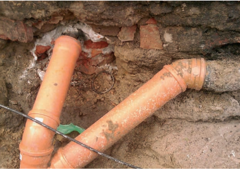
Baustelle an einer Abflussleitung
