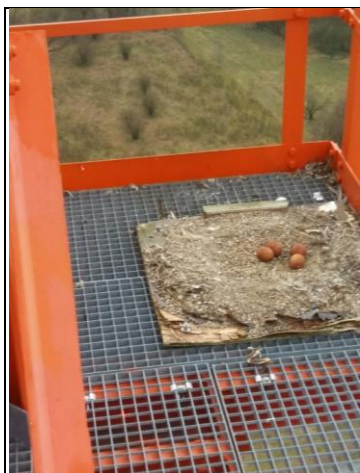
zerstörter Wanderfalkenkasten mit Eiern auf dem Telekommast Foto: Telekom
