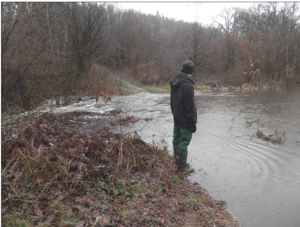
Überlaufender Stauteich (Wandserückhaltebecken) am 4.1.2018 Foto: W. J.
