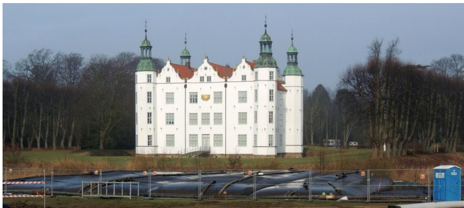
Der Schlamm wurde in 35 Meter langen und neun Meter breiten Säcken auf der Wiese vor dem Ahrensburger Schloss zwischengelagert.
