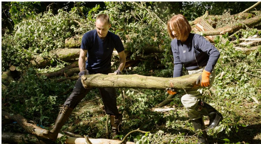
Als Strömungselement wurde Holz aus dem Sturmschaden eingebaut [Foto: M.Arlt]
