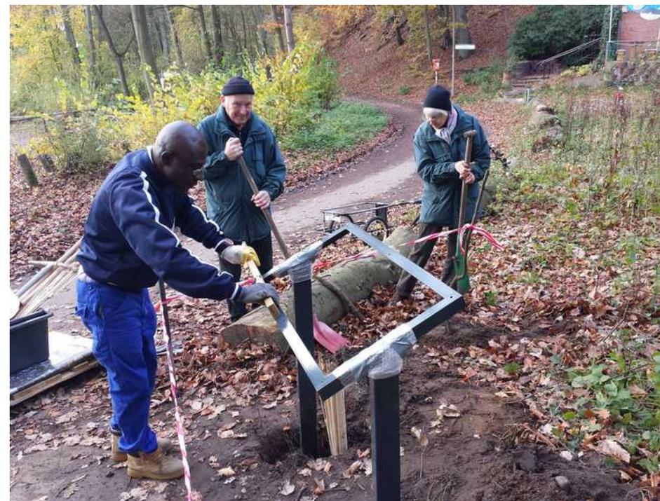
Abbildung 14: Installation der Tafelträger am Rissener Ufer beim Wittenbergener Teich
