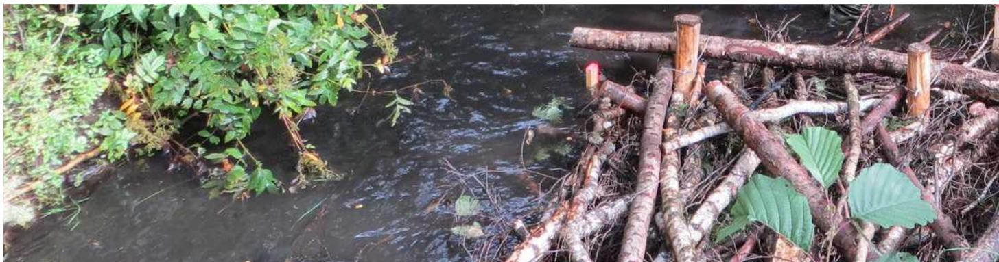
Abbildung 37: Wedeler Au: Höhere Fließgeschwindigkeit durch Strömungslenker
