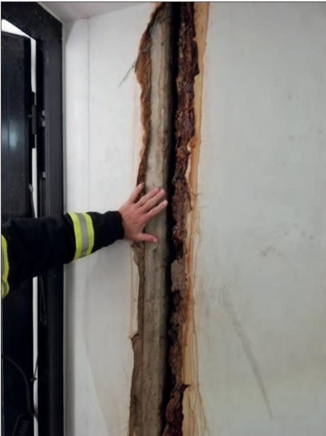
**Vertrackte Lage:** In der Trennfuge waren in früheren Jahren brennbare Baustoffe verbaut worden, bei Heißarbeiten hatten sich dort Glutnester gebildet. Um sie zu lokalisieren und zu löschen, bedurfte es einer kräftezehrenden Leistung und den Einsatz einer speziellen Hubarbeitsbühne
