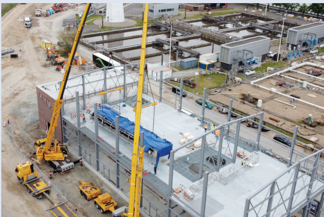
Abbildung 38: Baustelle Phosphor-Recycling-Anlage auf dem Klärwerk Hamburg
