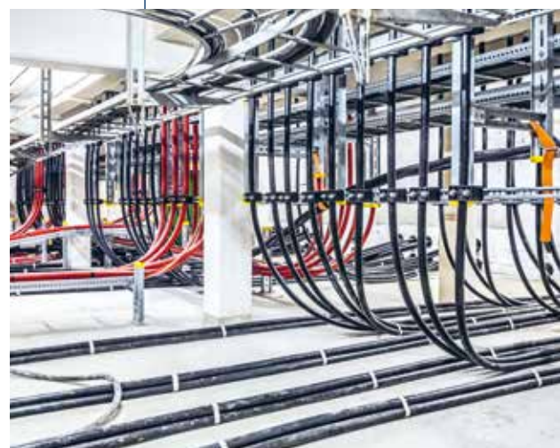
Neue Kabel für die Modernisierung des Netzes
