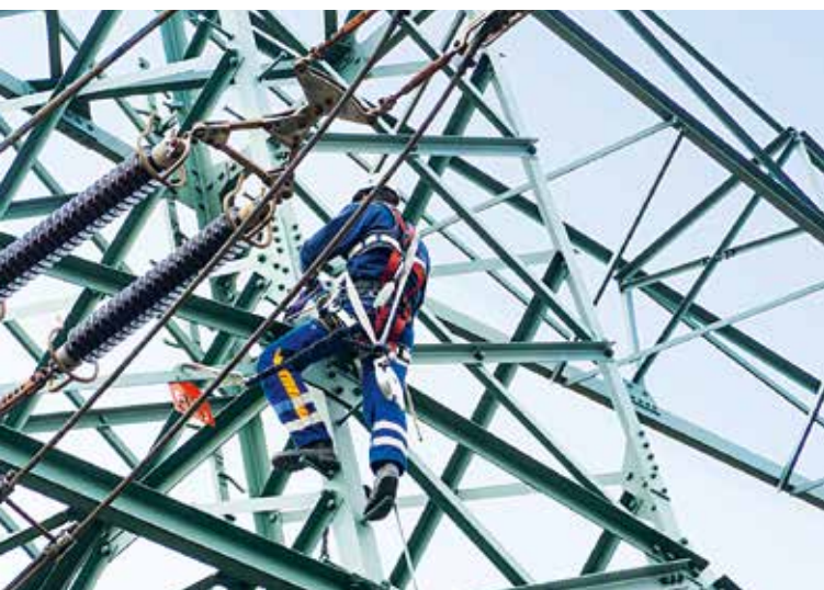
Regelmäßige Inspektionsarbeiten am Hochspannungsmast
