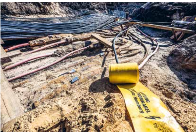
Bei Erneuerungen werden Altkabel fachgerecht entsorgt
