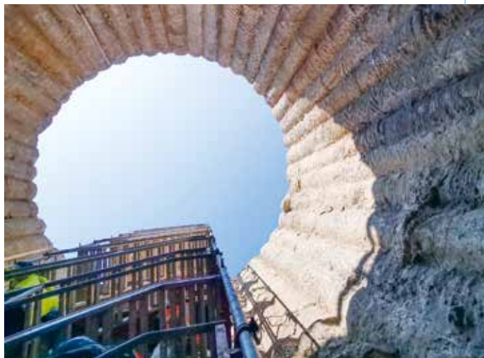
Blick aus der 20 Meter tiefen Startgrube der Tunnelbohrmaschine
