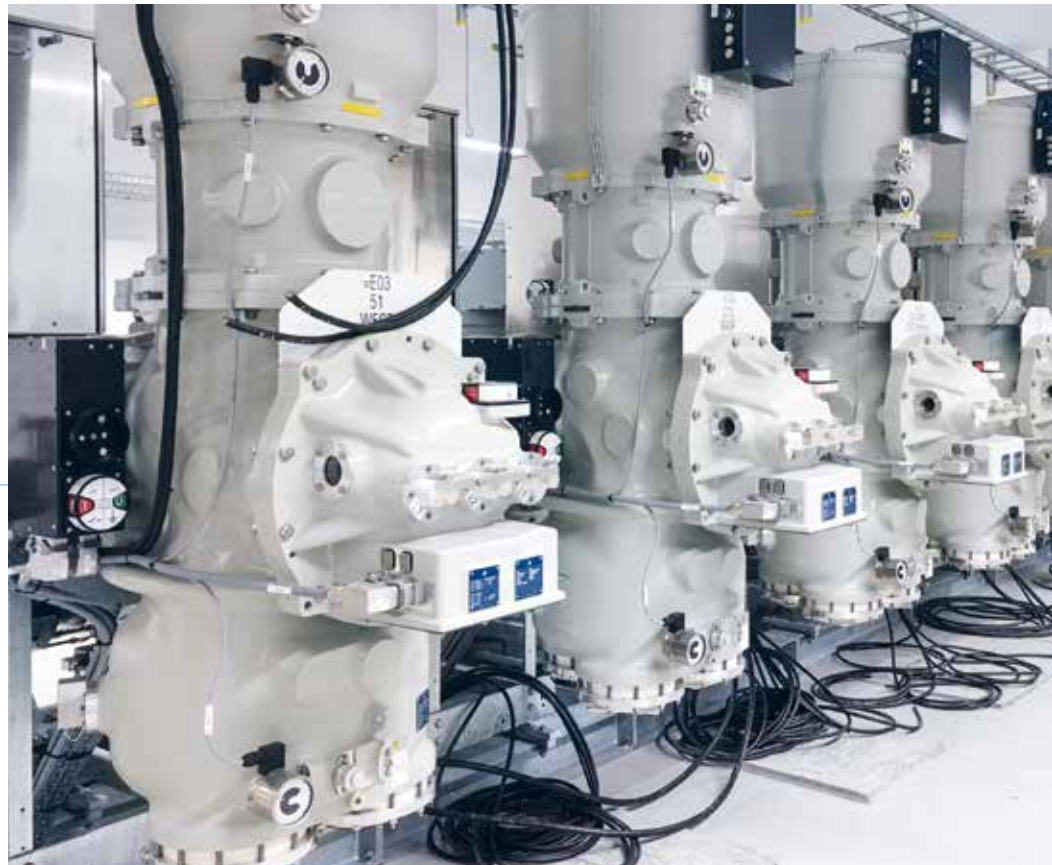
Neue Hochspannungsschaltanlage im Umspannwerk Bahrenfeld
