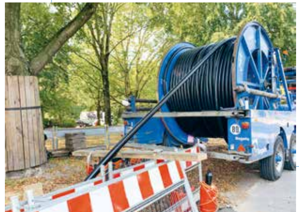
Verlegung von Hochspannungskabel
