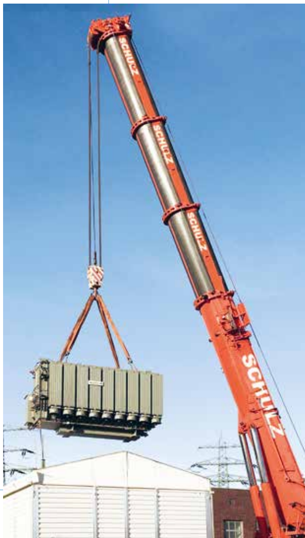
Ein neuer Trafo für das Umspannwerk Alsterdorf geht auf Transport.
