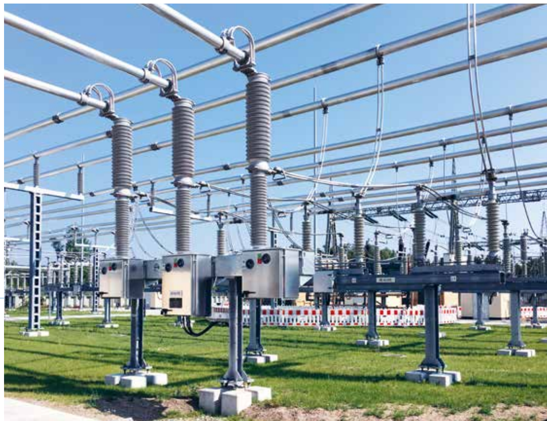
110-kV-Freiluftschaltanlage - erster Bauabschnitt
