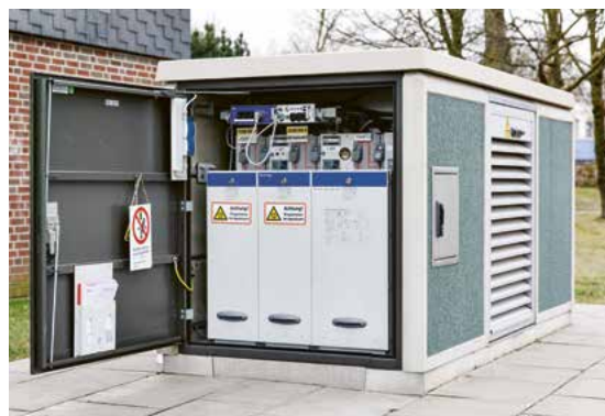
Moderne, fernsteuerbare Netzstation
