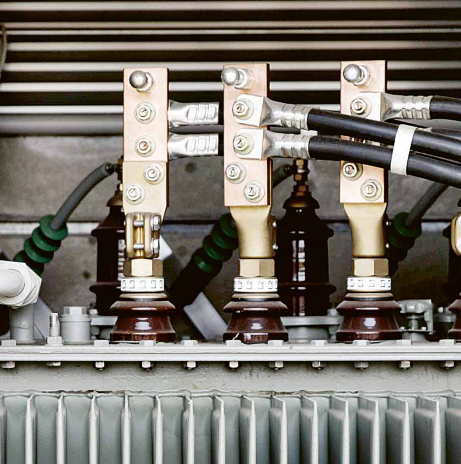
Mittelspannungs- zuführung zum Trafo
