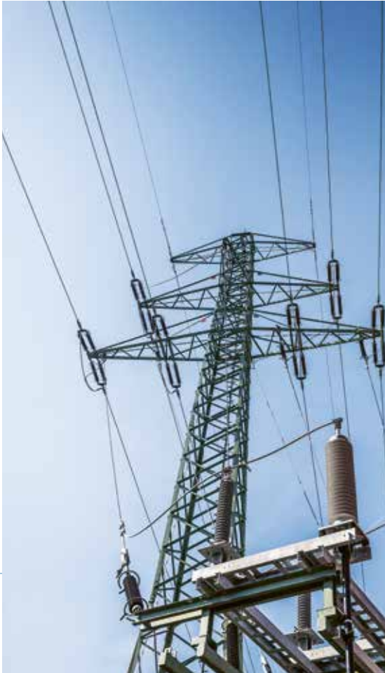
110-kV-Freileitung mit Abspanner zu nahestehendem Umspannwerk
