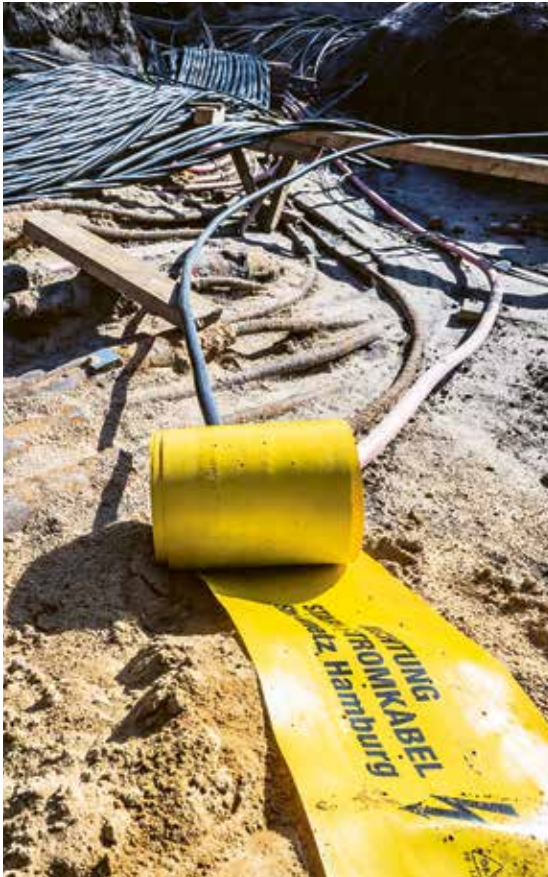
Sicherheit geht vor – Schutzmaßnahmen bei der Stromkabelverlegung
