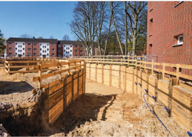
In drei neuen Tiefgaragen entstehen 112 Stellplätze.
