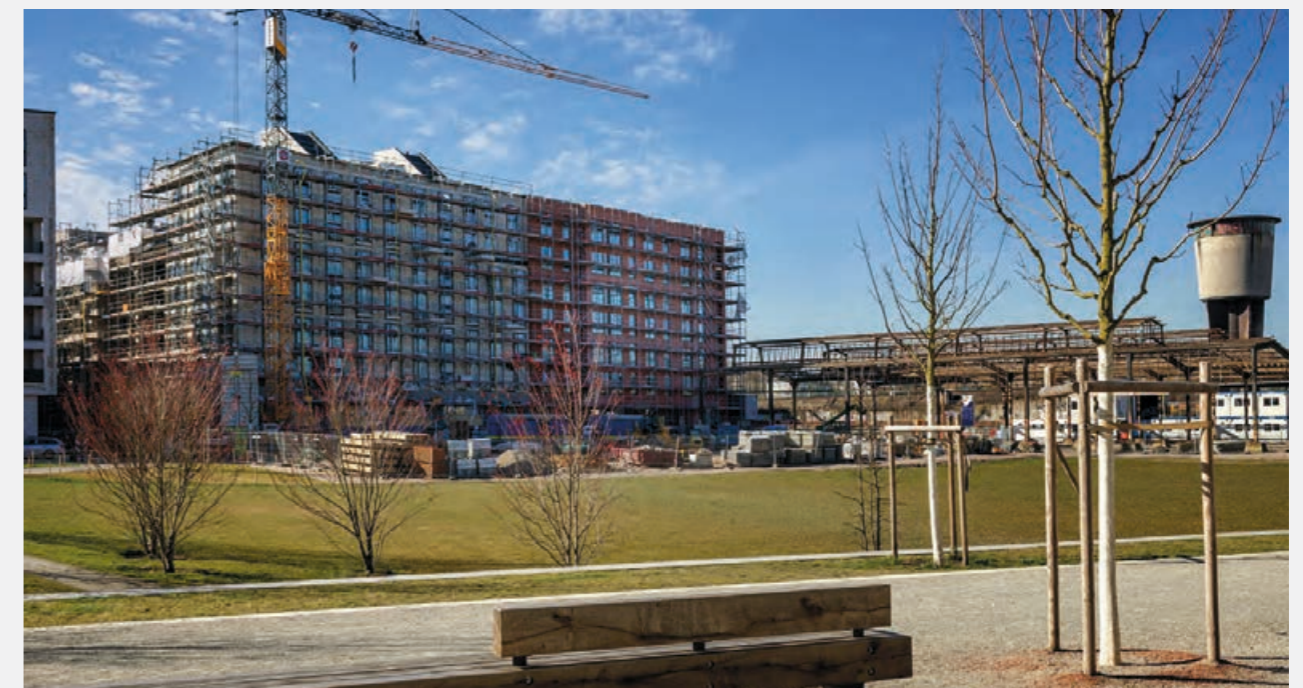
Direkt am neu angelegten Quartierspark entsteht der Gebäudeteil der Hamburger Wohnen (rechts im Bild).
