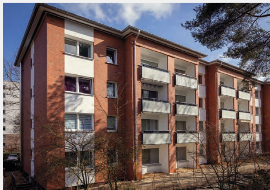
Die Ende 2019 fertiggestellte Fassade der Volksparkstraße 7–11
