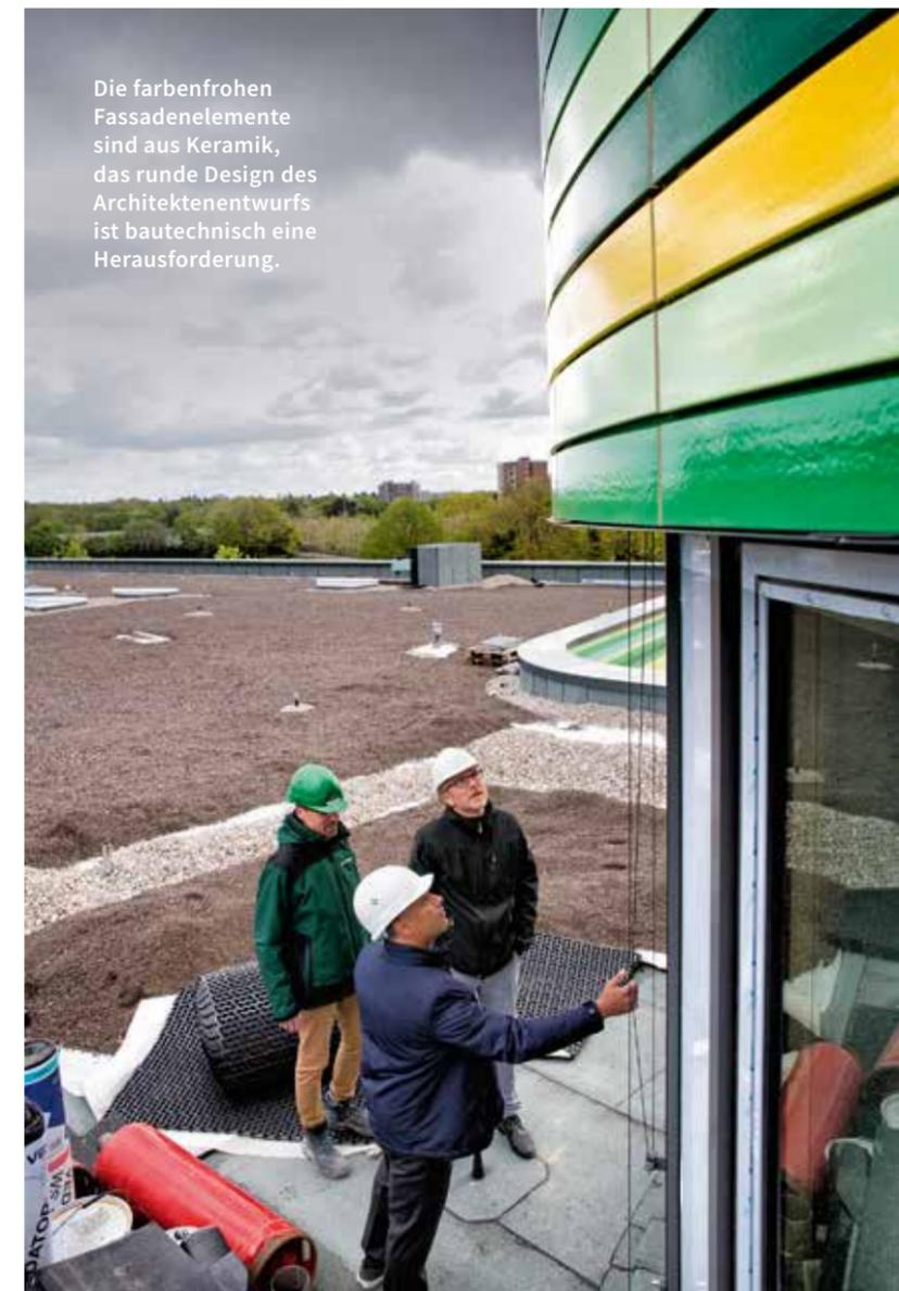
Die farbenfrohen Fassadenelemente sind aus Keramik, das runde Design des Architektenentwurfs ist bautechnisch eine Herausforderung.
