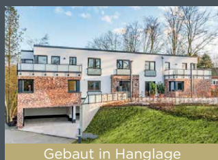
Gebaut in Hanglage
