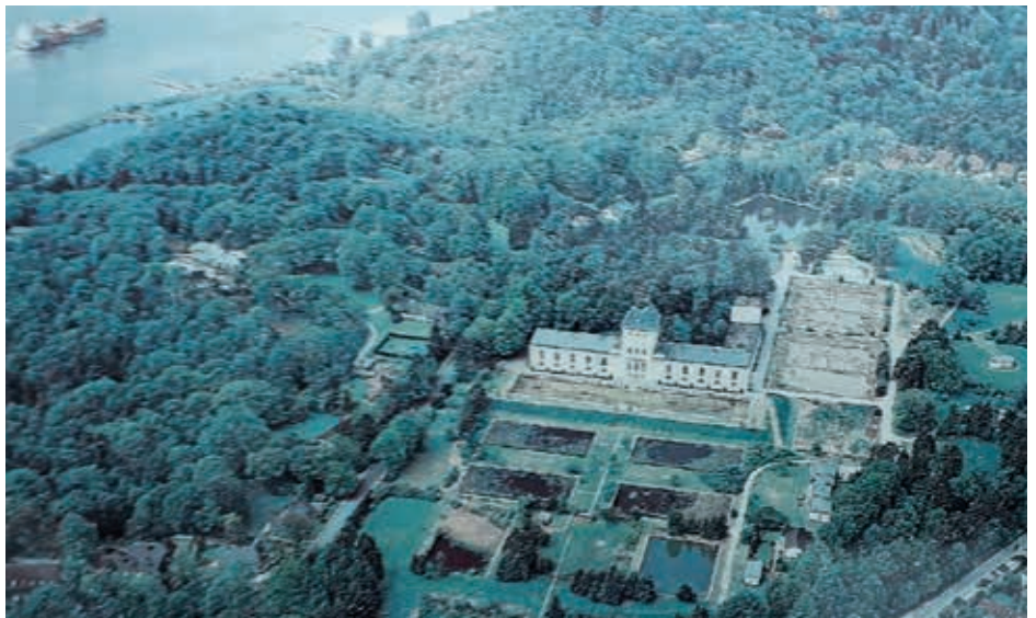
Luftbild des Wasserwerks Bursberg von 2005
