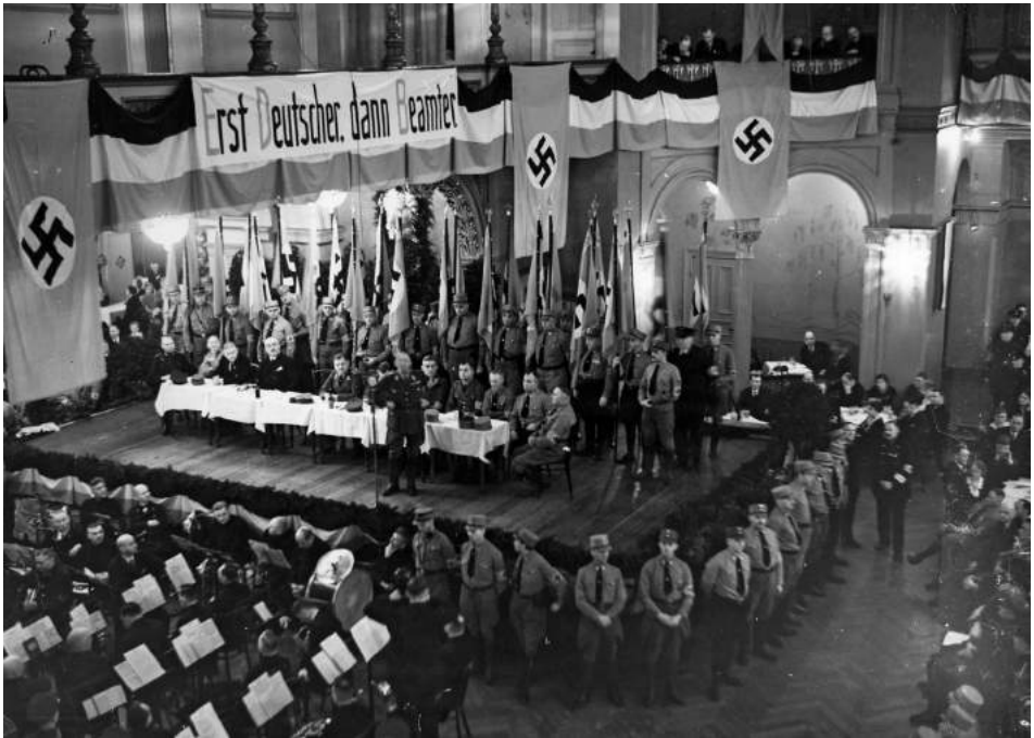
Bis 1933 war das Curio-Haus die Stätte der Hamburger Reformpädagogen. Danach veränderte sich das Bild: Schon 1934 dominierten Fahnen, Formationen und Saalschutz bei einer Beamtenversammlung.
