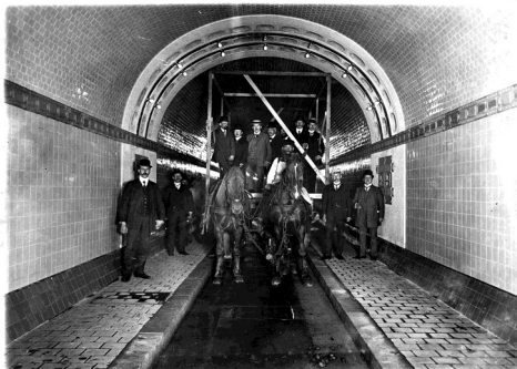
Die Fahrstreifen mussten breit genug für Pferdefuhrwerke sein, lautete eine der Vorgaben beim Bau des Tunnels.
