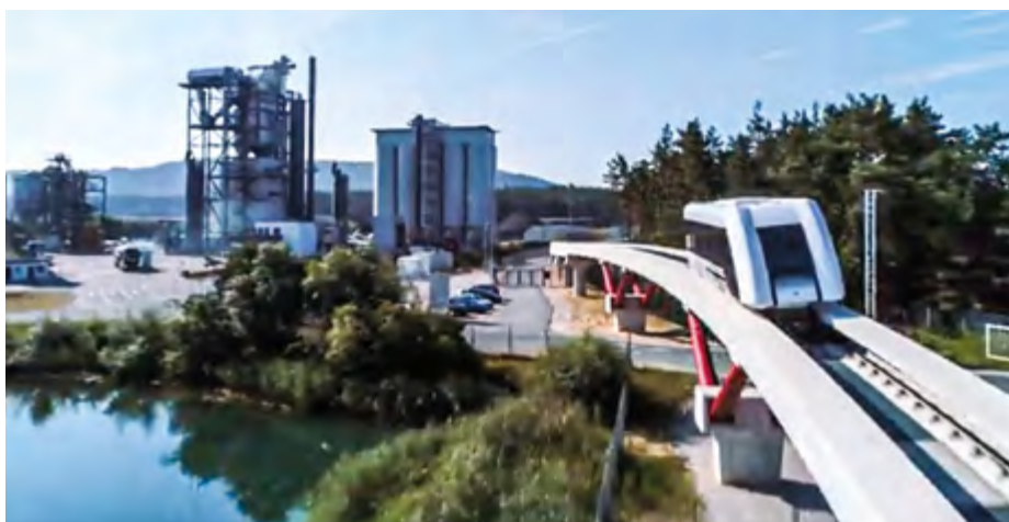
Ein Prototyp fährt bereits auf der 900 Meter langen Teststrecke
