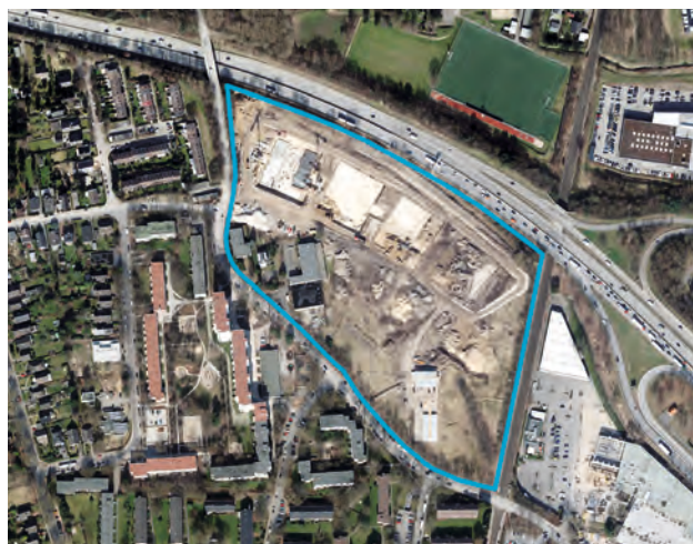
Der Standort Hörgensweg südlich der A 23
