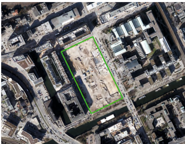
Rund um den SonninPark entstehen zahlreiche neue Wohnflächen
