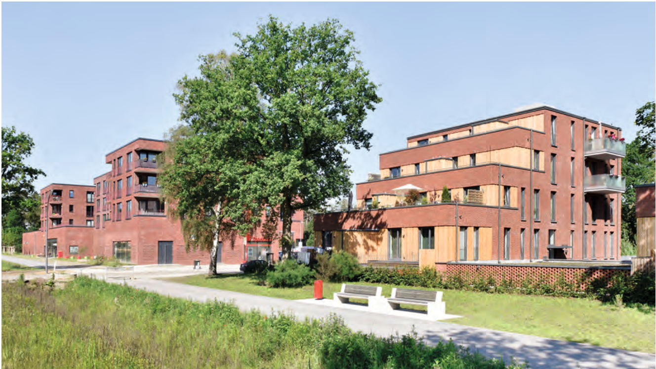
Großzügige Freiräume neben der Fischbeker Heide: das Quartier Fischbeker Heidbrook
