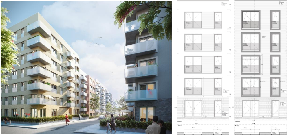
Äußere Gestaltung, Klinkerriemchen/ Putz beim SAGA-Systemhaus Quelle: NH Studio, SAGA
