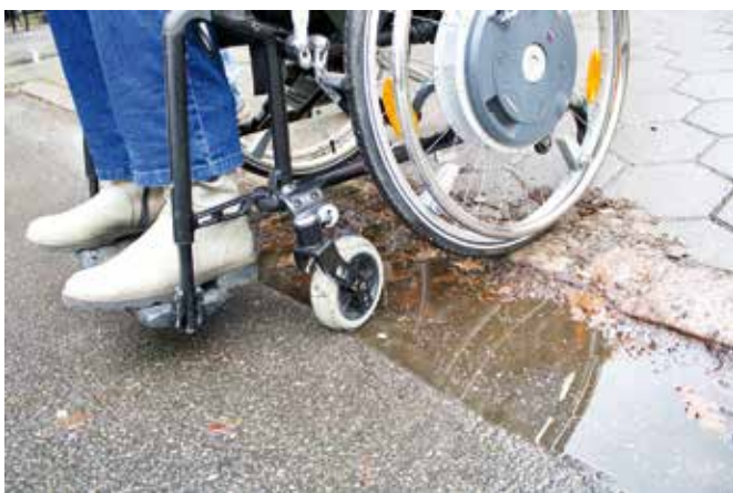
Wenn der Rollstuhl zur Falle wird: An der Finkenau bleiben die Räder der Rollstühle in der Regenrinne der Fahrbahn hängen. Foto: CDU Hamburg-Nord
