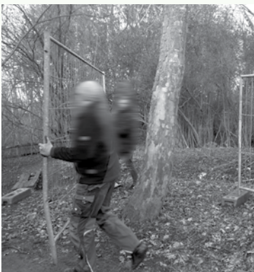
Der Zaun wird während der bereits laufenden Fällarbeiten aufgestellt.
