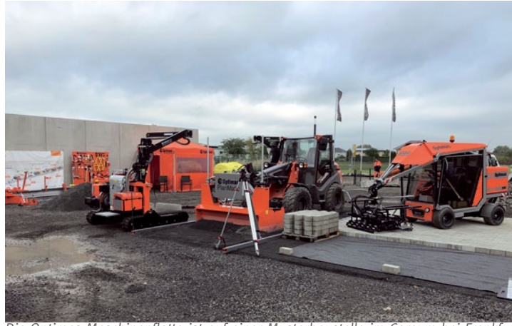
Die Optimas-Maschinenflotte ist auf einer Musterbaustelle im Coreum bei Frankfurt am Main zu testen. (Optimas GmbH)
