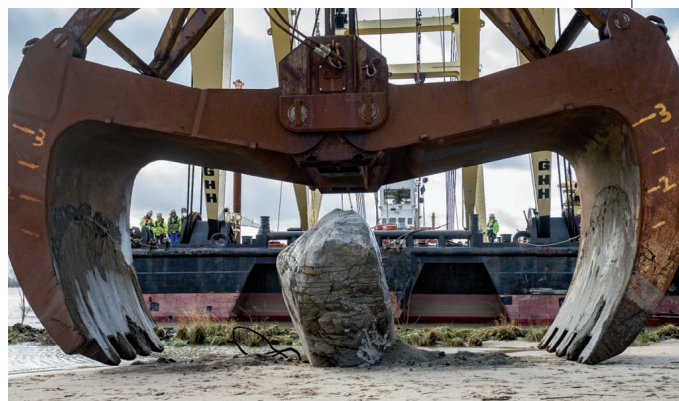
Auch mit den 60 Tonnen Gewicht kam der Kran gut klar ...
