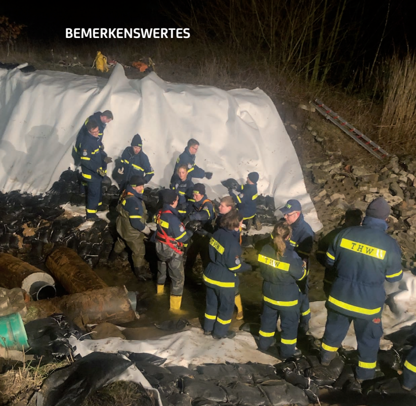
Mit GroÙeinsatzen auch nachts reparierten die Einsatzkräfte des THW die Dämme und Deiche im Naturschutzgebiet
