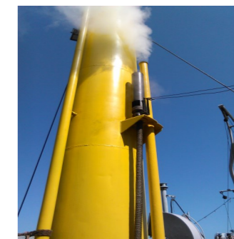
Der frisch reparierte Schornstein der „Saatsee“.
