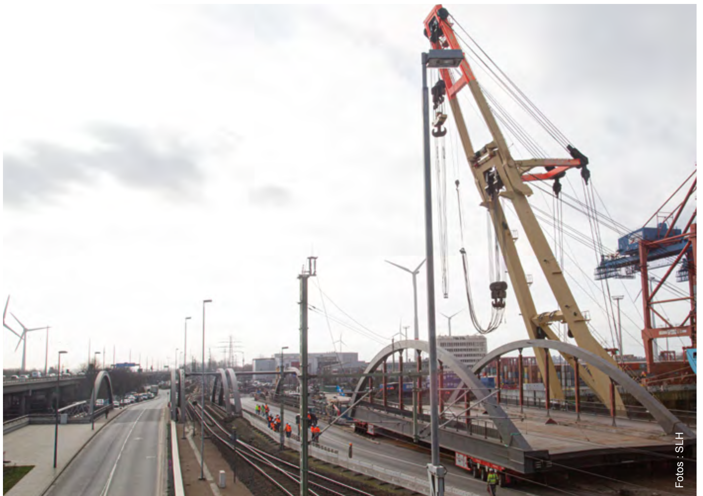
Die linke Straßenbrücke führt zum Altenwerder Damm, die rechte Straßenbrücke wird später zur Bahnlinie
