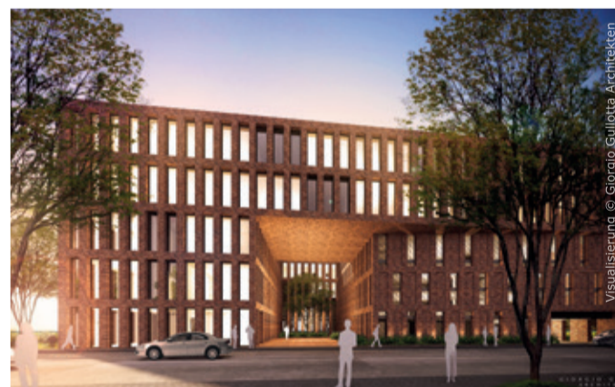
Neues Projekt: fünfstöckiges Gebäude in der Theodor-York-Straße
