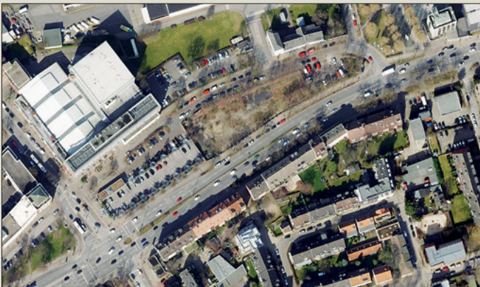
Luftbild vom 5.10.2018 der »Wandsbeker Zollinsel« zwischen der Rüterstraße und Wandsbeker Zollstraße. Foto: Freie und Hansestadt Hamburg, Landesbetrieb Geoinformation und Vermessung
