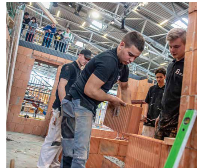
Live-Baustelle Die Besucher erleben mit, wie während der fünf Messetage in Halle C 3 ein Haus entsteht.
