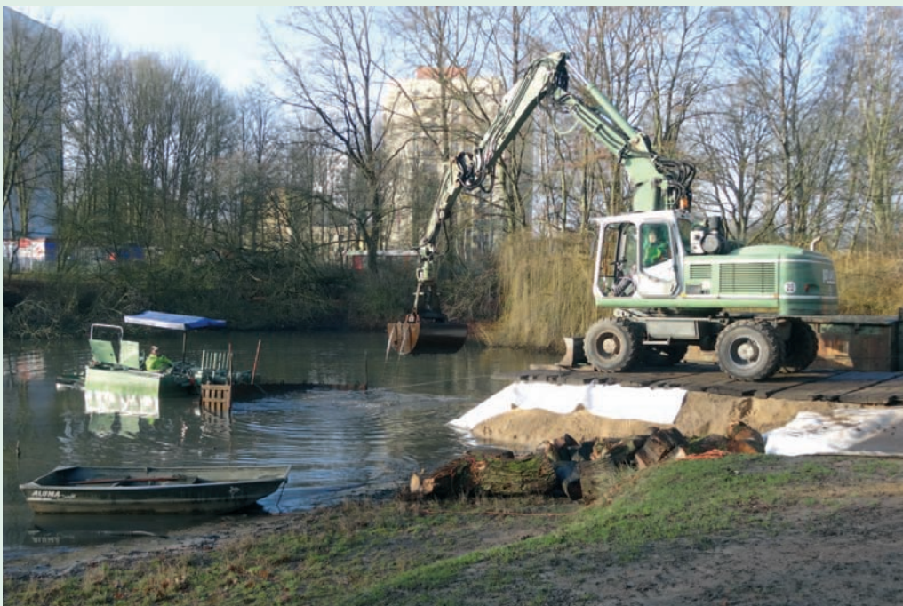
Bagger bei der Reinigung
