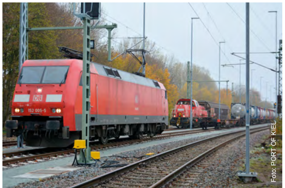
Das neue Rangiergleis in Kiel-Meimersdorf ist nun 200 Meter länger
