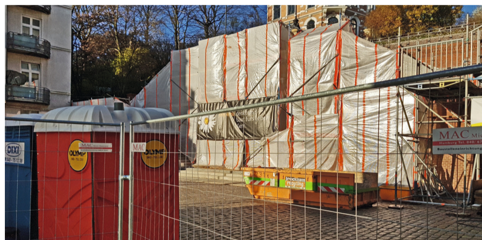
Köhlbrandtreppe: Sanierung hat begonnen
