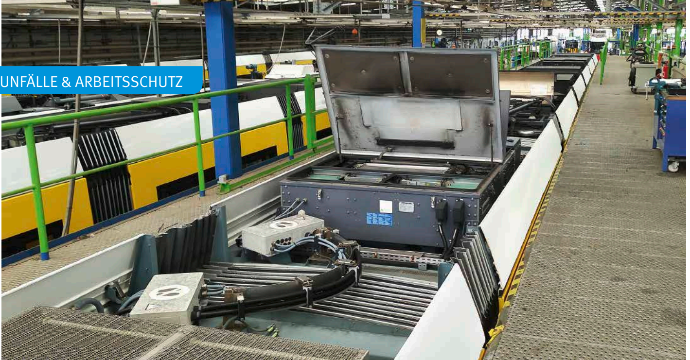
Die Arbeitsfläche eines Straßenbahndacharbeitsstandes (Zwischen dem Bild und dem geschilderten Unfall besteht kein Zusammenhang)
