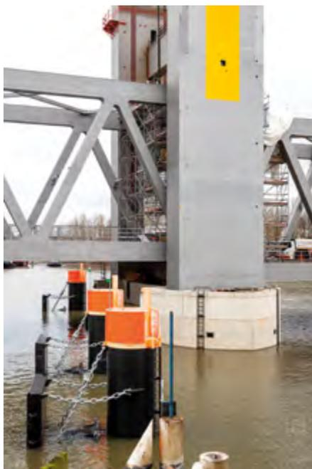
Pass: Die Brücke ist eingehängt Tiefe am Elbgrund wurde der Boden mit Hochdruckstrahlern beiseite gespült. Größere Hindernisse wie Fußball-große Steine mussten Taucher per Hand beseitigen. Insgesamt wurden die Fundamente
