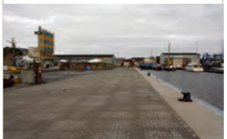
**Emden** – NPorts wird im Laufe dieses Jahres zwei Hafenteile für insgesamt 2 Millionen Euro saniert haben. Bereits abgeschlossen sind nach einem halben Jahr Bauzeit die Arbeiten auf der westlichen Seite des Borssumer Hafens (Foto). Die Kaianlage wurde auf einer Länge von rund 100 Metern instandgesetzt worden. Am Nordufer im Industriehafen wird nun die vor über 100 Jahren errichtete Kaianlage zurück gebaut.
