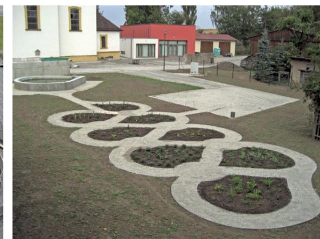
Die Profile werden im Werk in Fürstzell genau nach Architektenplan vorgebogen und auf das exakte Längenmaß geschnitten. Jede einzelne Profilverbindung wird beschriftet und auf dem Plan vermerkt. Auf der Baustelle müssen die einzelnen Elemente nur noch miteinander verschraubt werden. Der Aufbau der Randeinfassungen ist schnell und einfach. Der Verarbeiter spart
