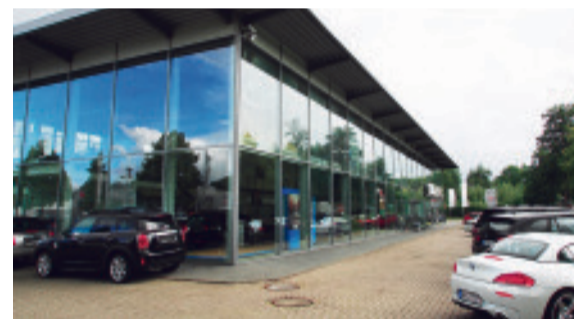
Baugleich wie der STADAC-Standort Buchholz: das BMW-Autohaus in Norderstedt.
