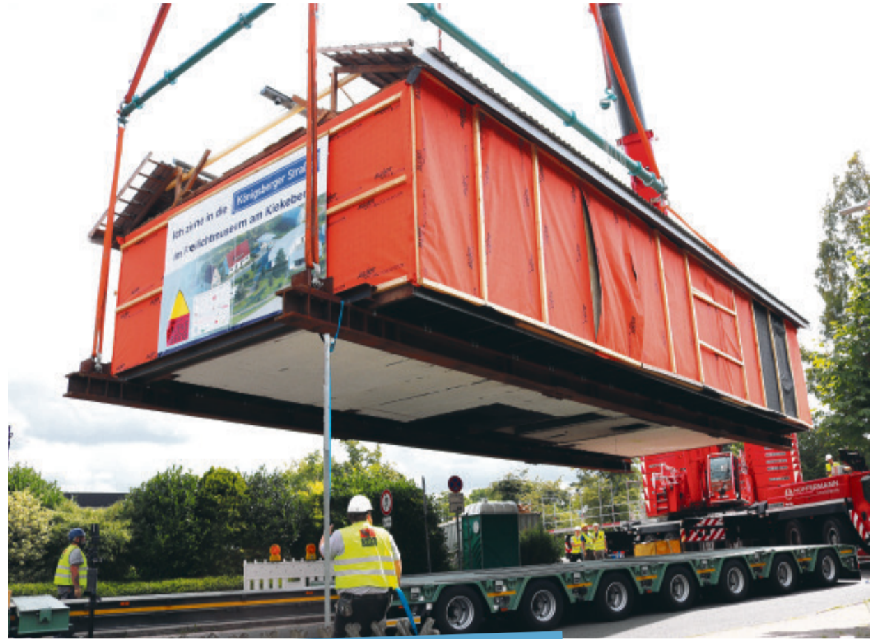
Der spannende Moment: Der etwa 40 Tonnen schwere Hauskorpus wird auf den Tieflader gestellt. Fotos: FLMK
