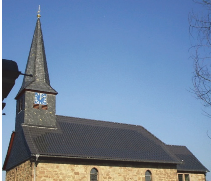
Abbildung 94: Katholische Kirche mit Solardachziegeln in Rohrberg/Burgwalde (Quelle: dbu.de)
