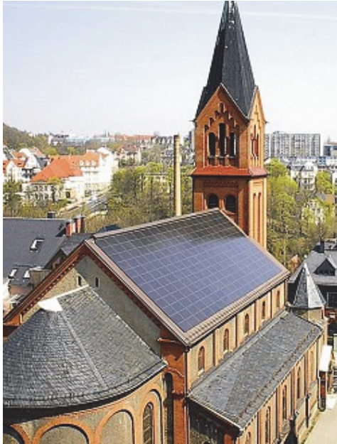
Abbildung 93: PV-Anlage auf der Herz-Jesu-Kirche Plauen. (Quelle buergerkraftwerk.de)
