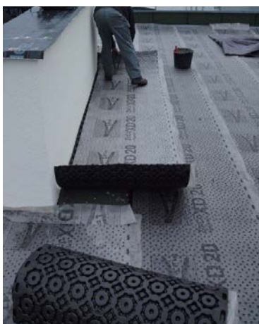
Abb. 3: Einbau der Drainagematten (links) und fertiggestelltes Gründach (rechts)
