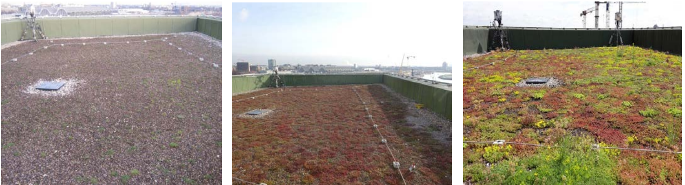
Abb. 4: Entwicklung der Pflanzenbedeckung am Nordteil des Gründachs im Februar 2015 (links, Bedeckungsgrad < 20%), März 2016 (mitte, Bedeckungsgrad ~ 70%) und Juni 2017 (rechts, Bedeckungsgrad ~ 90%).
