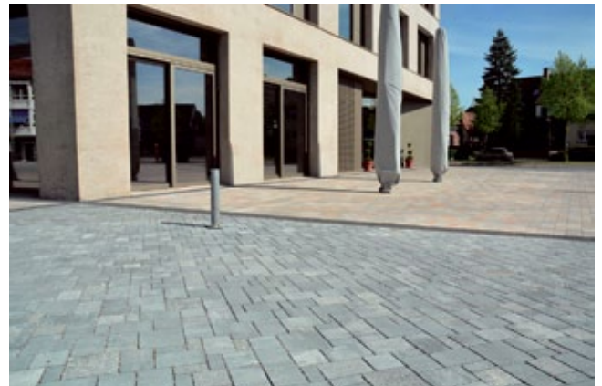
Vor allem für die befahrenen Flächen rund um das neue Rathaus in Remchingen verwendeten die Planer das Pflastersystem CombiStabil Natura. (Foto: Beton-Pfenning)
