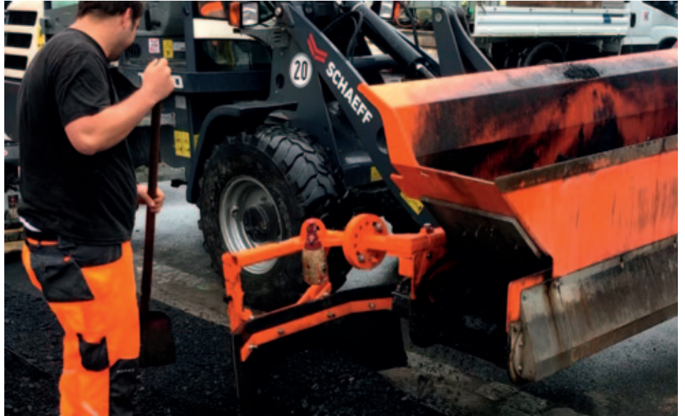
Die Material-Verteilschaufel „Finliner“ von Optimas kann direkt vom Lkw beladen werden und dies, falls erforderlich, auch mit Asphalt. (Foto: Optimas GmbH)
