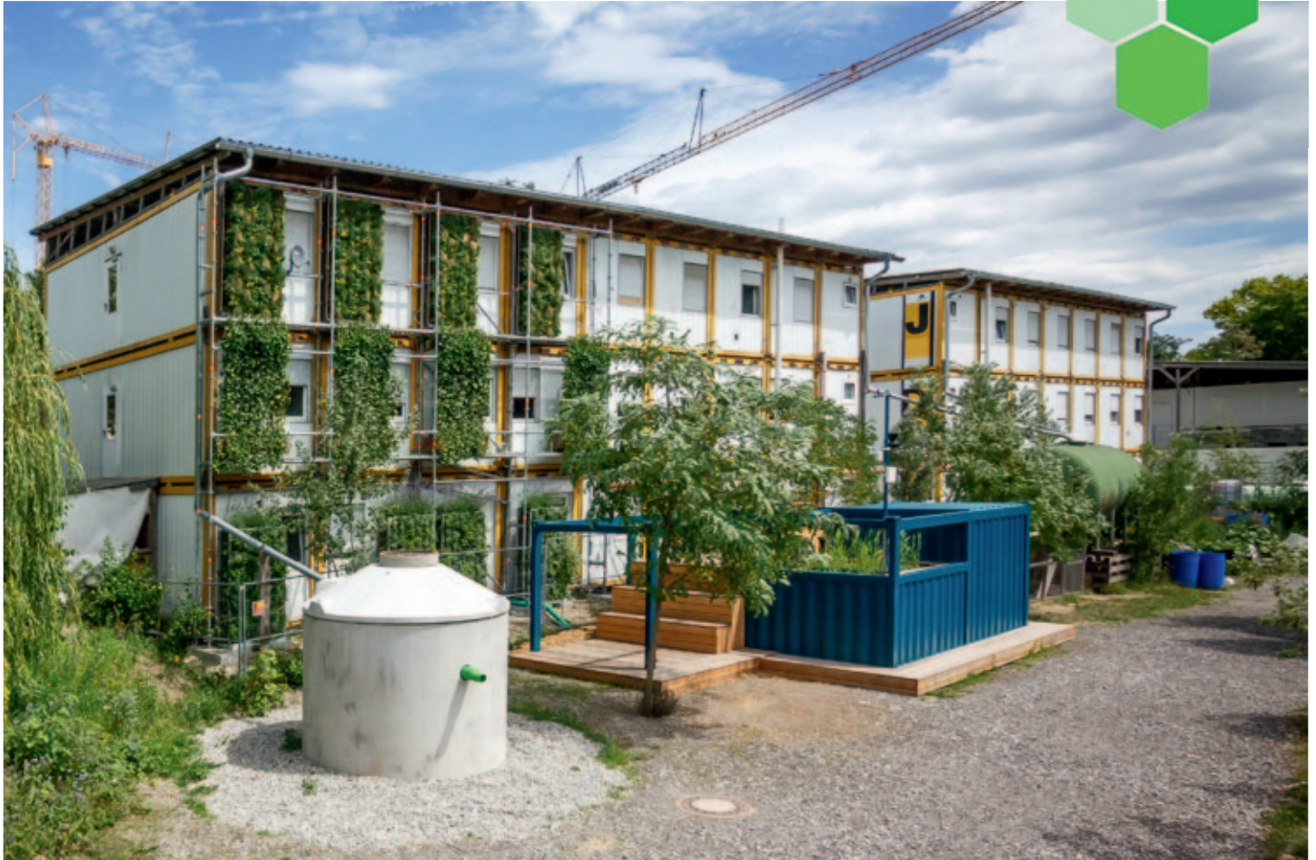
Für die Versorgung der Fassadenbegrünung wird zum einen Regenwasser von der Dachfläche in einer Retentions-Zisterne gespeichert (li.), zum anderen wird auch der Abfluss aus den Duschen der Wohncontainer in einer Pflanzenkläranlage (re.) aufgefangen. (Foto: Julian Rettig)
