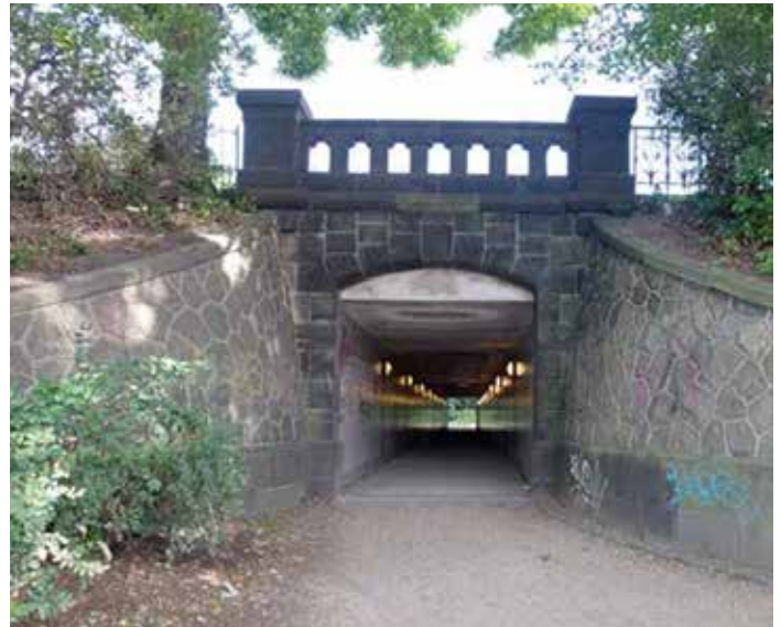
Eingang Fußgängertunnel von der Binnenalster - Bestand
