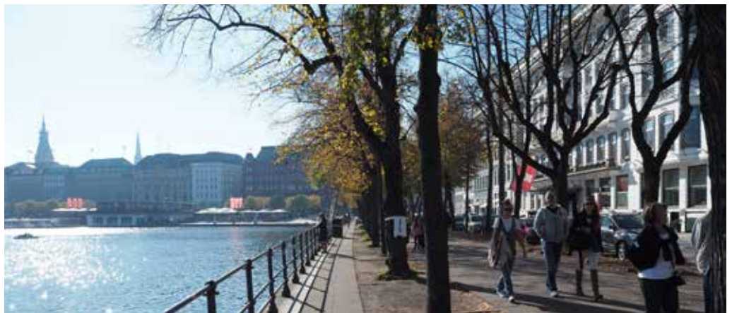
Promenade mit Stützmauer und Geländer, Blickrichtung nach Süden
