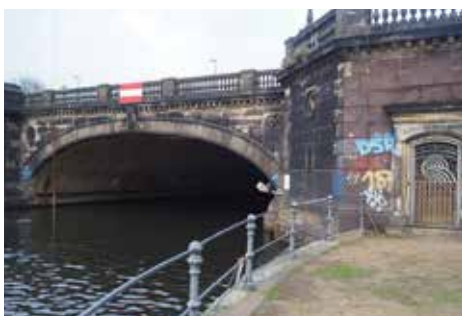
Dampfbootwartehäuschen im Osten
