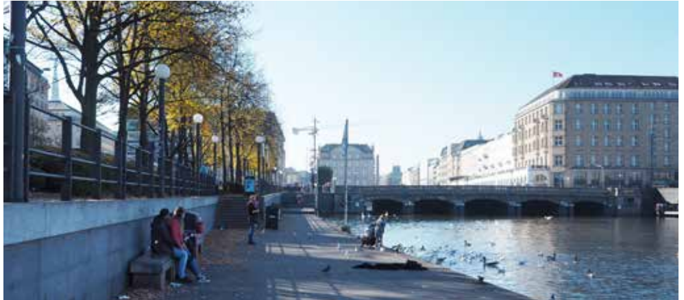
Steganlage im südlichen Bereich des Ballindamms
