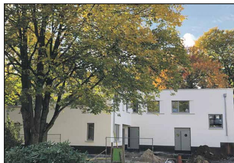
Der Neubau auf dem Gelände im Eißendorfer Pferdeweg bietet sechs Plätze für Kinder von sechs bis zwölf Jahren, die in ihrer Entwicklung stark belastet sind. Belegt werden kann ab Januar 2021. Foto: Sobot
