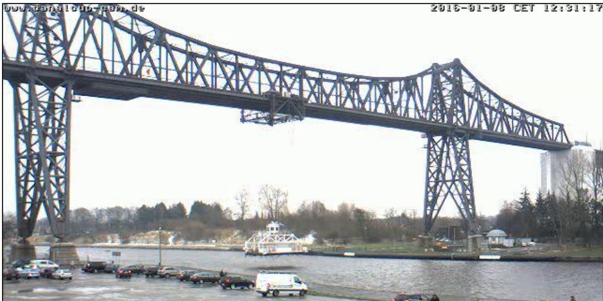
Abbildung 20: Position der Schwebefähre nach dem Unfall bei Tageslicht
