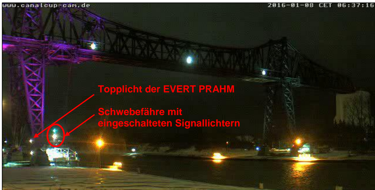
Abbildung 7: Schwebefähre schaltet die Signallichter ein, 08.01.2016, 06:37 Uhr Wenige Sekunden später ging die Brückenbeleuchtung aus (vgl. Abbildung 8).
