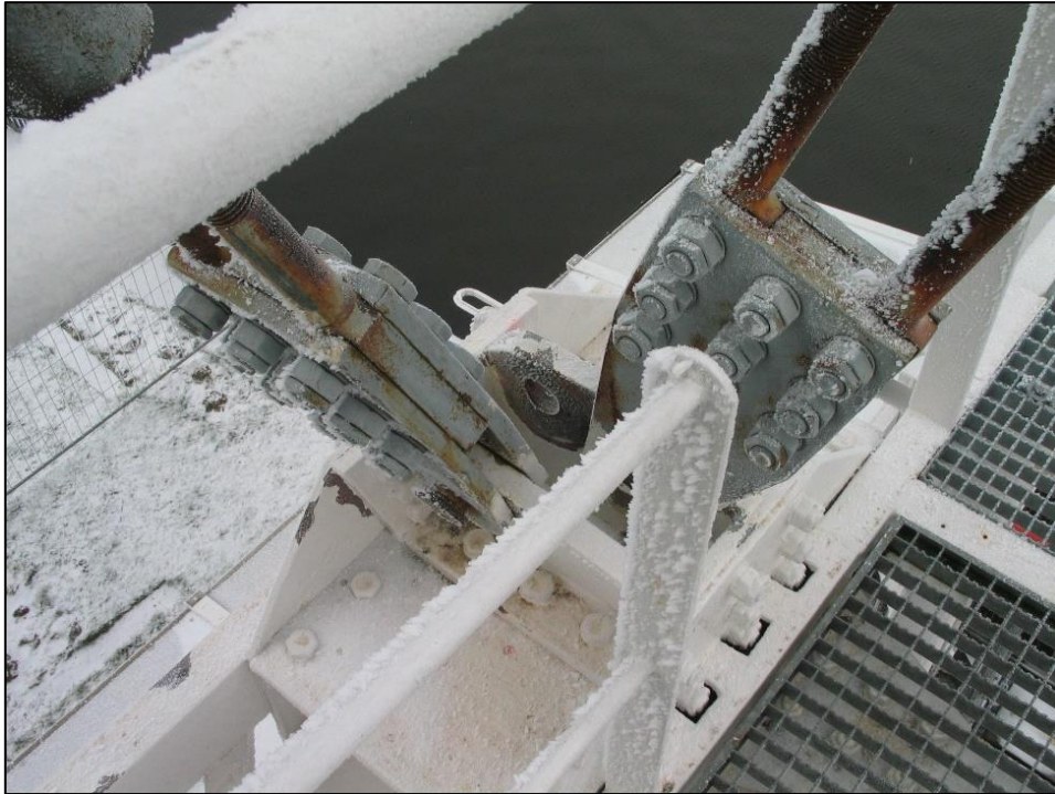
Abbildung 43: Befestigungspunkt für die Seile auf der Nordwest-Seite
