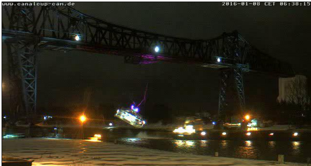
Abbildung 11: Pendeln der Schwebefähre nach der Kollision, 08.01.2016, 06:38 Uhr
