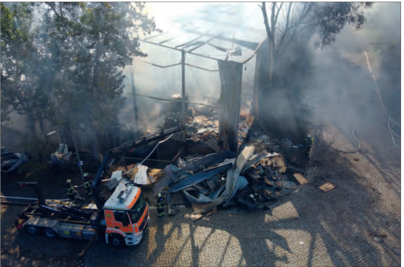
Rauch- und Feuerpilz über Wilhelmsburg: Die Lagerhalle, voll unterkellert, steht im Vollbrand, Trümmerteile fliegen nach der Explosion von Propangasflaschen umher. Die Löscharbeiten ziehen sich über fünf Tage hin, die Halle muss schließlich abgerissen werden
